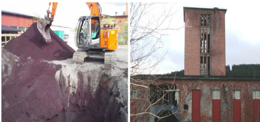
Bild 13-14. Provgrop vid åtgärdsförberedande undersökningar i Järpen samt en bild på den fallfärdiga gamla sprittfabriken som planeras att rivas. Foto: Golder Associates respektive Länsstyrelsen Jämtlands län.
