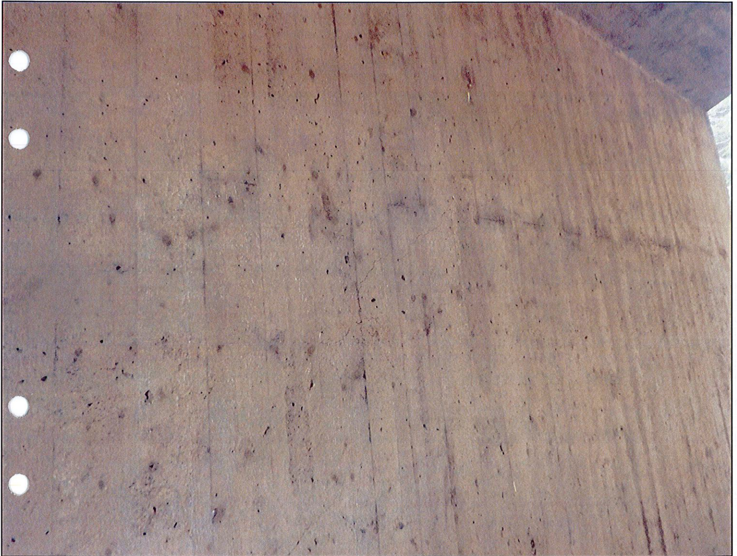
3 - Frontmur - Armerad betong - Dragspricka 2016-10-06
