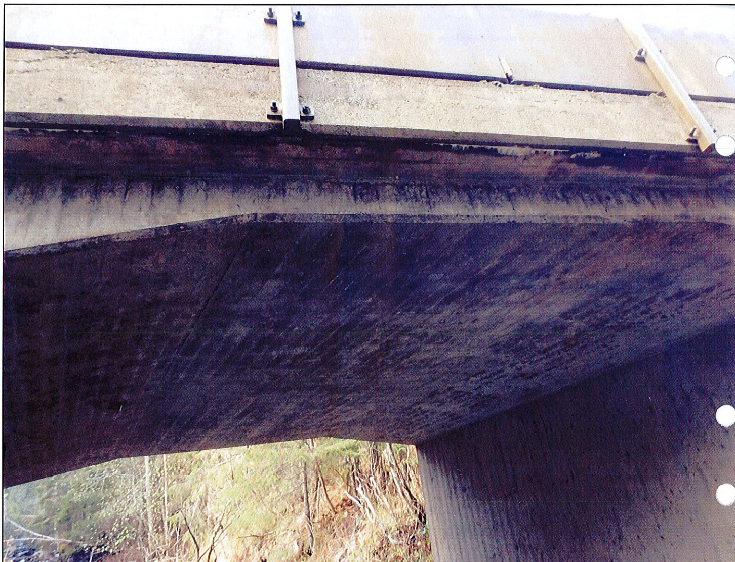
4 - Tätskikt - Membran - Läckage 2016-10-06
